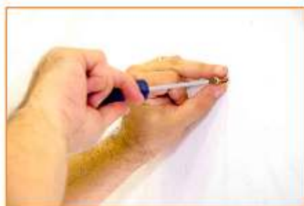
3- Aplicar o parafuso na bucha prendendo a peça a ser fixada
